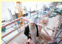
на строительном участке храма иконы "Всех скорбящих Радость" (с-рошники), 18 января 2019
