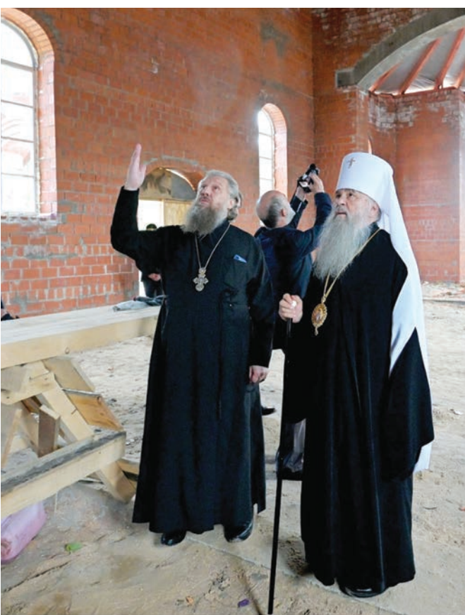
В строящемся храме свят. Тихона, Патриарха Московского
