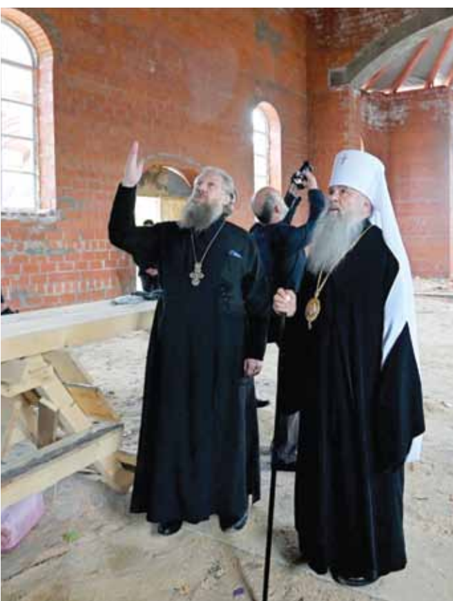
В строящемся храме свят. Тихона, Патриарха Московского
